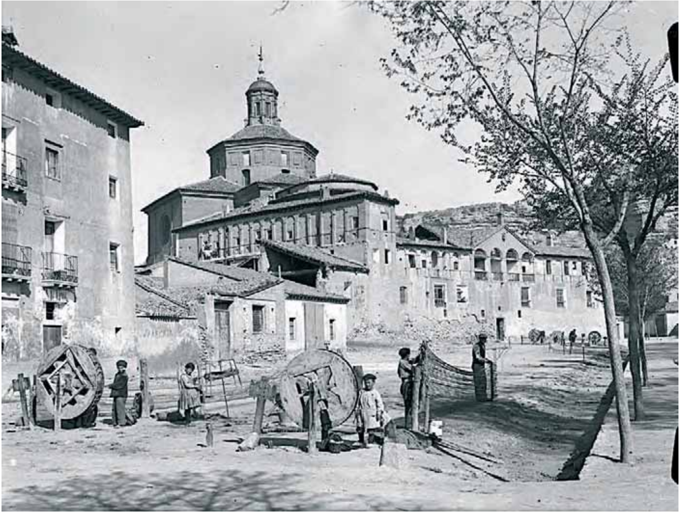
En Calatayud, instalando el tendido eléctrico.
