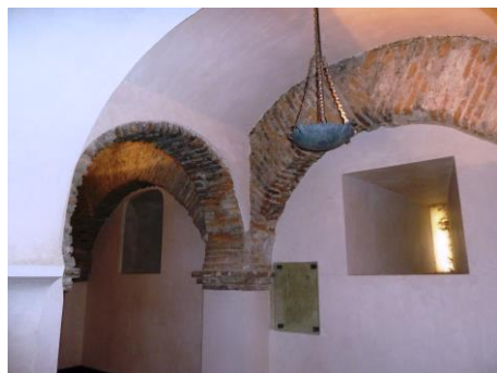
Torre del Homenaje. Planta 2ª. Tramo norte hacia el norte.
