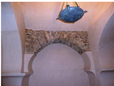
Torre del Homenaje. Planta 2ª. Tramo noreste hacia el este.
