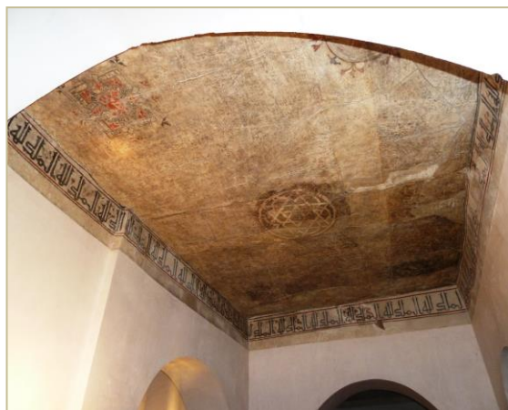
Torre del Homenaje. Planta 3 a . Tramo central sur hacia el oeste.
