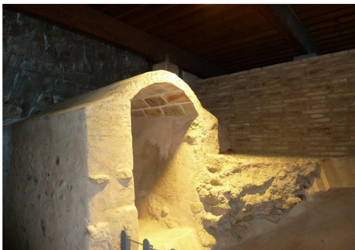
Comunicación pozo-aljibe a Torre del Homenaje.
