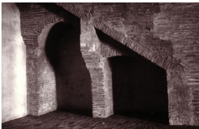
Torre del Homenaje. Planta 5ª. Escalera mudéjar.
