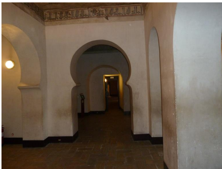
Torre del Homenaje. Planta 3 a . Tramo central sur hacia el oeste.
