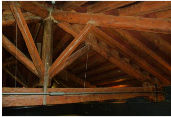
Torre del Homenaje. Planta 6ª. Armadura de la cubierta.
