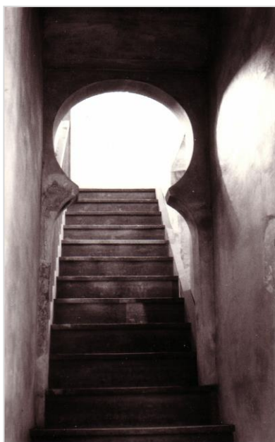
Torre del Homenaje. Escalera de planta 3 a a 4 a . Ascenso.
