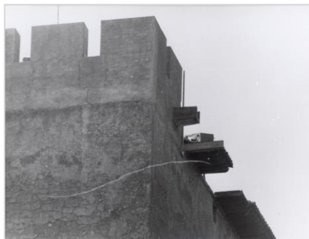
Torre del Homenaje. Recorte del alero y recercamiento de las almenas. (Hurtado Ojalvo).
