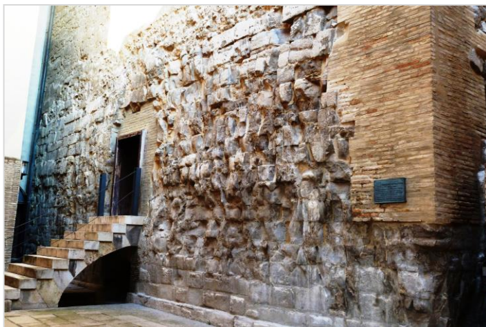
Torre del Homenaje. Esquina sureste.
