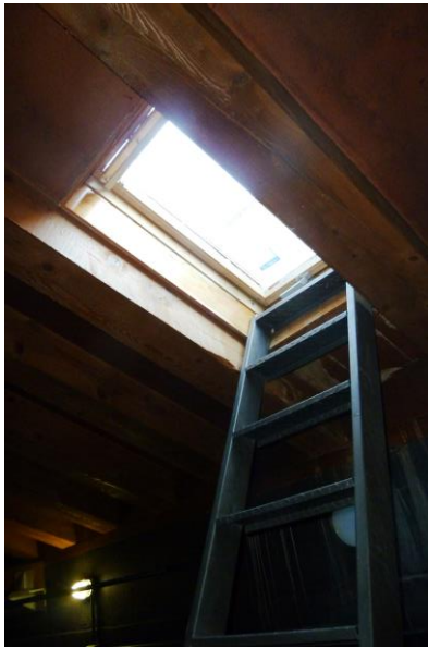
Torre del Homenaje. Planta 6ª. Acceso a cubierta.
