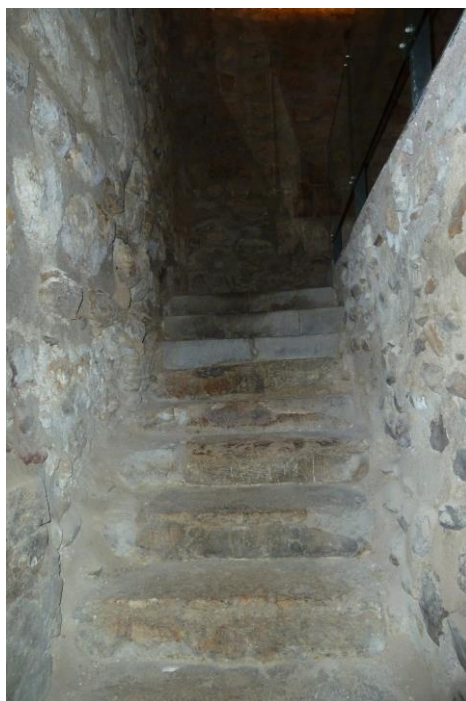
Escalera comunicación pozo-aljibe a Torre del Homenaje.
