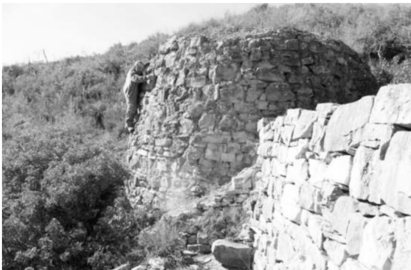
Foto nº 43. Forn de Rosildo en Riba-roja d'Ebre. Se observa el volumen del exterior del edificio.
