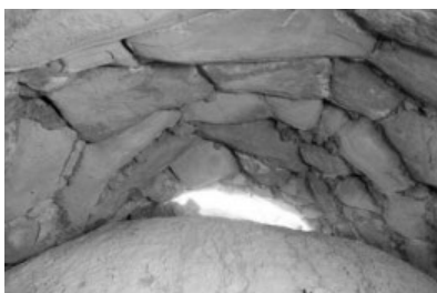
Fotos nº 59 y 60. Interior de la cámara de combustión del forn de Mariano Balanses de Riba-roja d'Ebre, en el que se puede apreciar el desgaste de las piedras por la acción del fuego.
