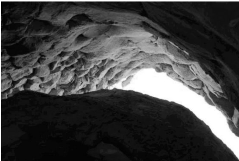
Foto nº 54. Interior del horno de Bovera visto desde la boca del horno. Se observa la ausencia de hollín y el mayor desgaste en la zona vertical del tiro más intenso de las llamas.
