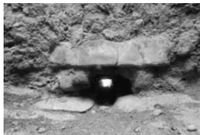
Foto nº 37. Drenaje de salida del líquido en el horno de Bovera, visto desde el interior.
