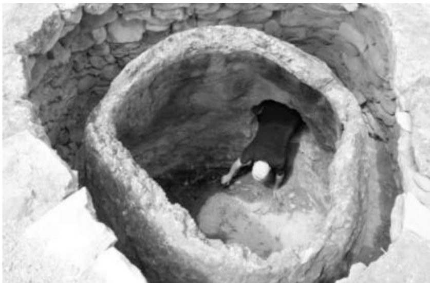
Foto nº 35. Horno de aceite de enebro de Bovera, restaurado pero truncado en su parte superior.
