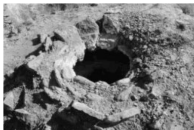
Foto nº 47. Boca de la chimenea del forn de Rosildo en Riba-roja d'Ebre. Se observa la forma del asentamiento de la losa de cierre en el muro del horno.
