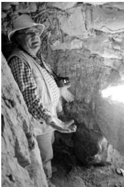
Foto nº 42. Interior de la cámara de combustión entre la camisa y el muro del horno, en el Forn de Mariano Balanses de Riba-roja d'Ebre. Se aprecia la anchura suficiente para encender y mantener el fuego.
