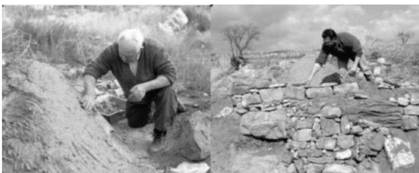
Fotos n° 24 y 25. Aplicando la mezcla de barro y paja sobre las losas de piedra.
