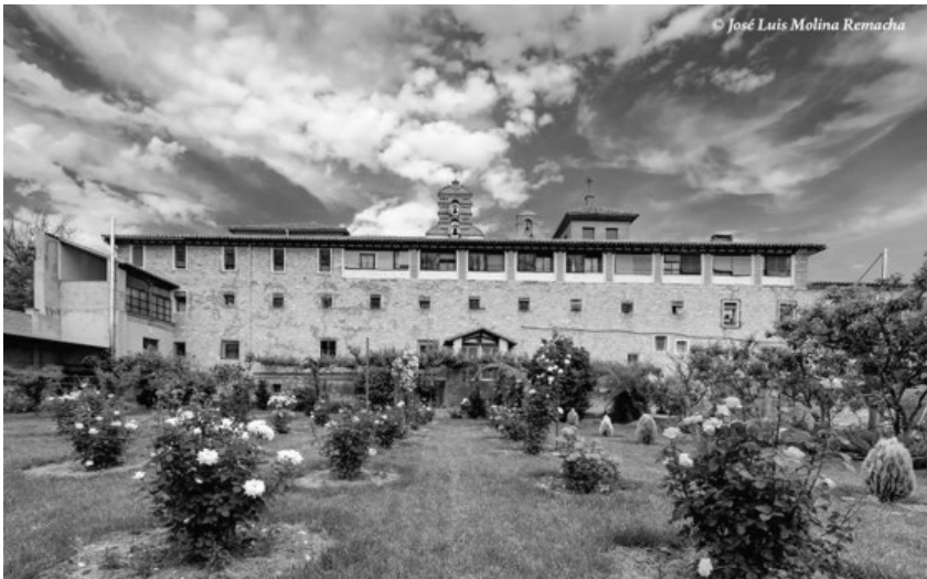
Figura 1. Vista del convento desde la huerta.
