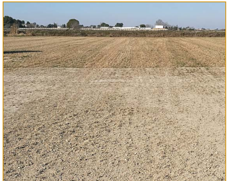
Detalle de la parcela tras el pase de cuchilla niveladora
