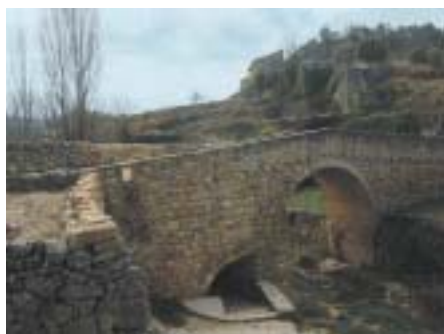
Puente de Torre de Arcas
