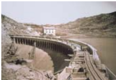
Construcción del pantano de Pena (concluido en 1930)
