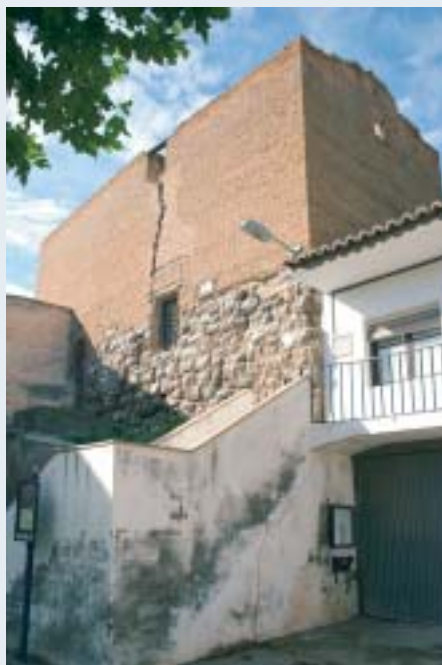
El torreón de Pleitas, en la actualidad
