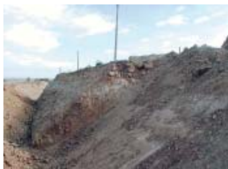
Aspecto del mismo punto anterior tras el desmontado de la vía por unas obras recientes en noviembre de 2002. Se observa la distinta composición de materiales de la franja del firme
