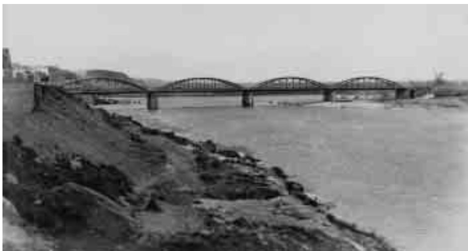
Puente de hierro en Gallur, sobre el Ebro (carretera de Gallur a Sangüesa), levantado en el lugar donde existió un paso de barcas
