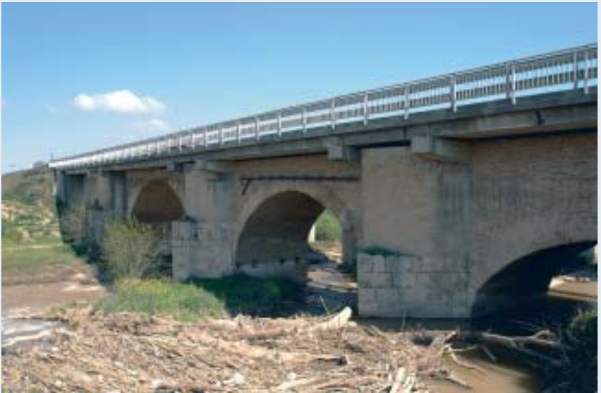
El puente de Alagón en la actualidad
