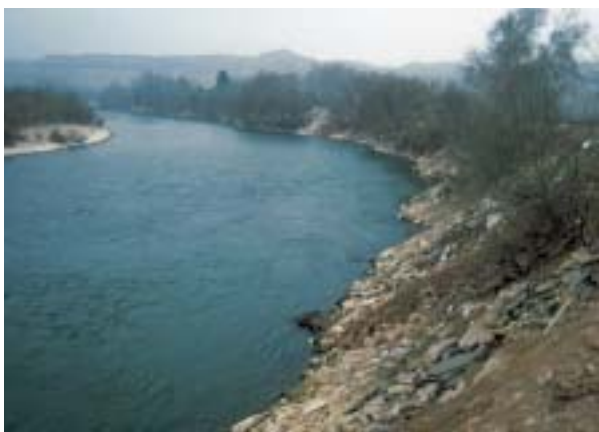
Vertido de escombros con fines defensivos en Pradilla
