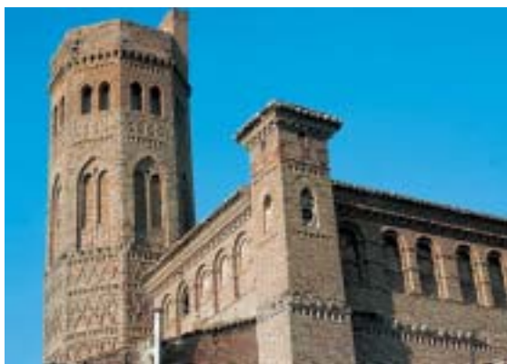
Exterior de la iglesia de San Pedro de Alagón, con la galería de arquillos de la segunda mitad del siglo XVI
