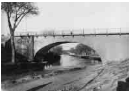
Puente sobre el Canal Imperial en Gallur
