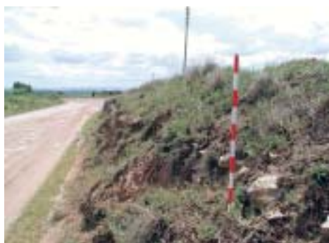
Restos de la cimentación del afirmado de la vía romana llegando a Mallén, en junio de 2002. Discurre en terraplén por la parte alta del talud
