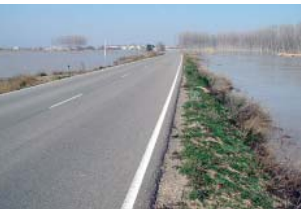
La carretera de Cabañas de Ebro (al fondo), próxima al trazado de la vía romana, afectada por la riada del Ebro. (08/02/2003)
