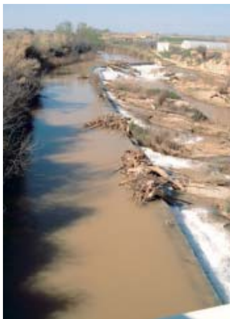
Azud de la Almozara, que sangra las aguas del Jalón para regar la antigua huerta de la derecha del Ebro hasta Zaragoza
