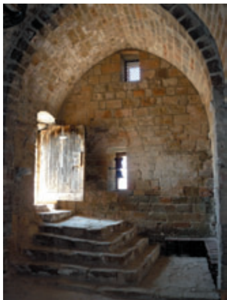
Interior de la ermita de San Bartolomé de Calasanz con escalinata de acceso al piso situado a nivel sensiblemente inferior
