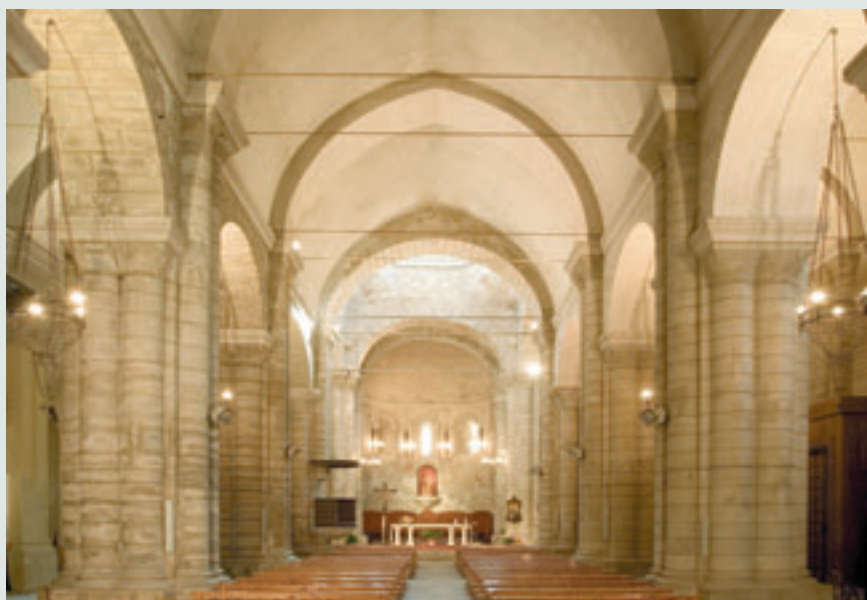
Interior de la nave y presbiterio
