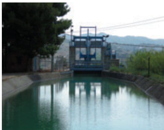
Compuerta de entrada al sifón de Albelda, una de las obras emblemáticas en la construcción del Canal de Aragón y Cataluña
