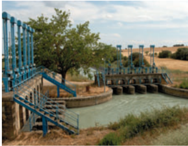
Vista del partidor de Zaidín, punto de inicio del canal secundario de su nombre, de 48 km de longitud y que riega algo más de 30.000 hectáreas
