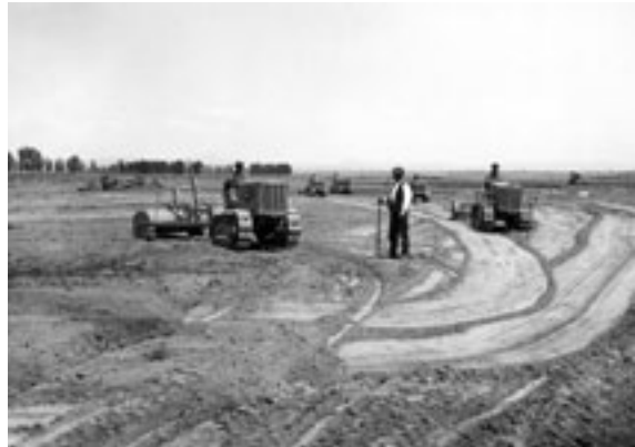
La puesta en riego supuso la realización de grandes trabajos de nivelación y la construcción de numerosos sistemas de drenaje. Finca de La Melusa, Tamarite, 1930
