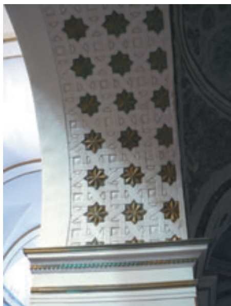
Lucerías mudéjares en el intradós de una capilla lateral de la iglesia de San Cipriano de Calasanz
