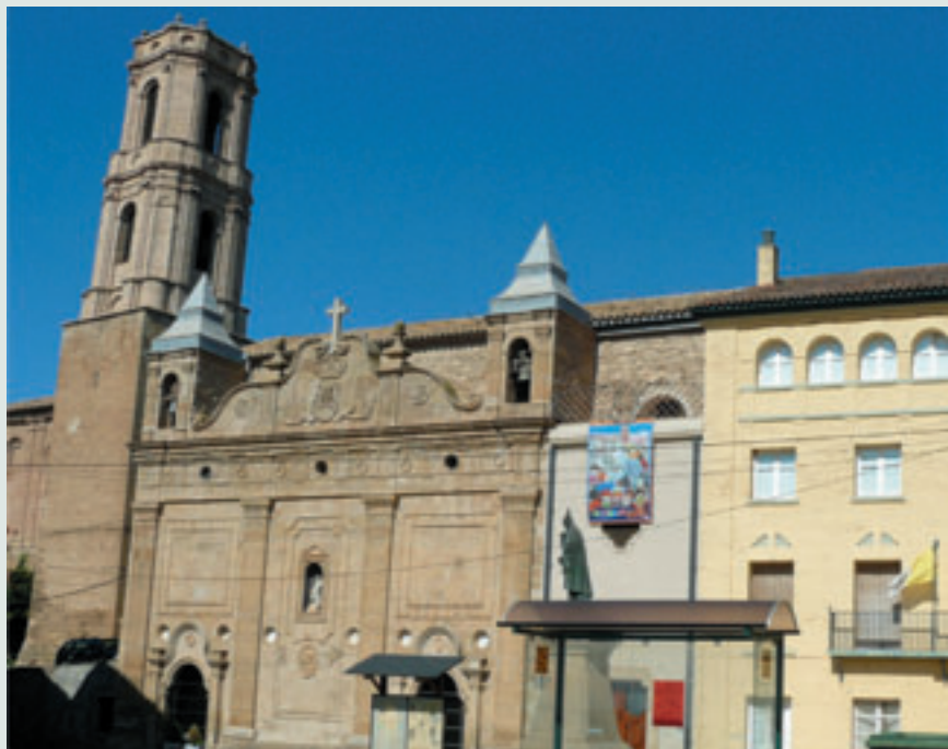
Conjunto escolapio en Peralta de la Sal
