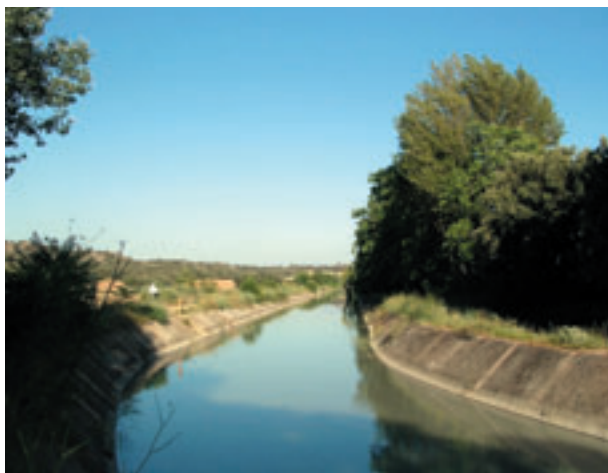
Vista general del canal a su paso por San Esteban de Litera
