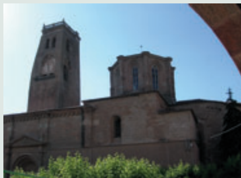
Vista exterior del templo con la portada principal románica y renacentista y el cimborrio gótico
