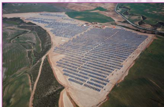
Instalación solar de 9 MW con seguidor a 1 eje. Zuera (Zaragoza)
