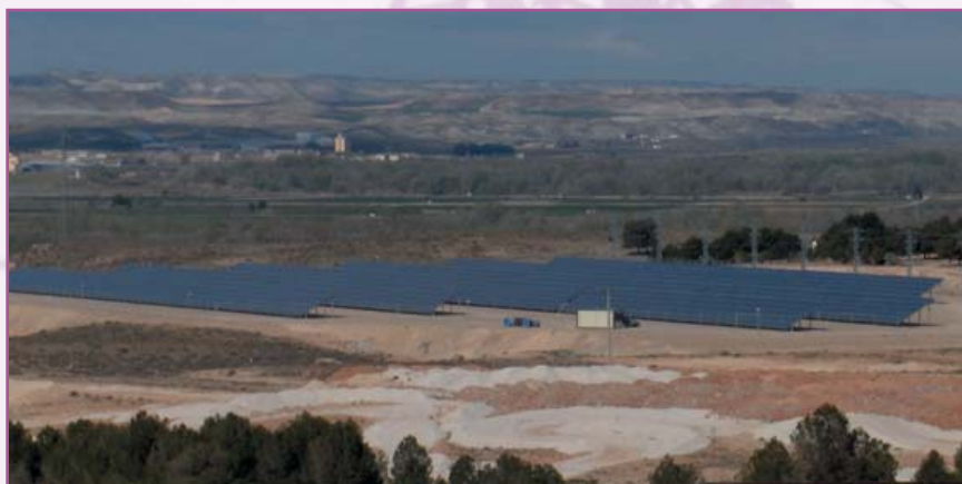
Instalación solar. Gelsa (Zaragoza).
