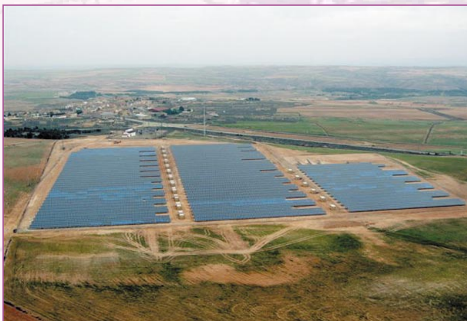
Instalación solar. Azaila (Teruel).
