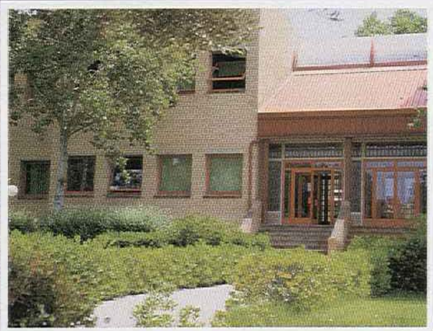
Instalaciones. Vista exterior del edificio del Centro de Protección Vegetal.
