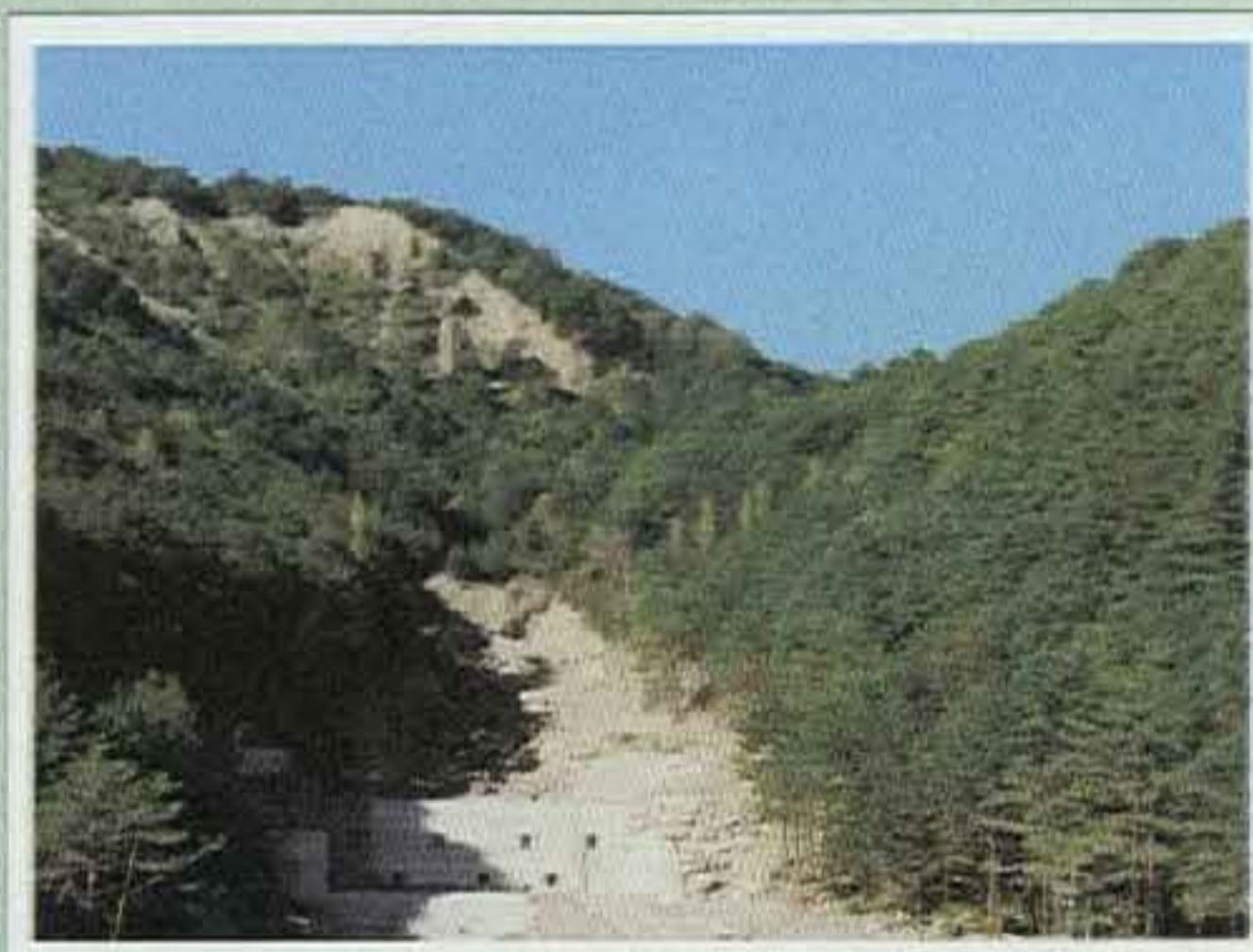
Dique 3 de la corrección actual. Puede verse el éxito de los trabajos de recuperación de la cubierta vegetal. Al fondo se aprecian las «Señoritas de Arás».
