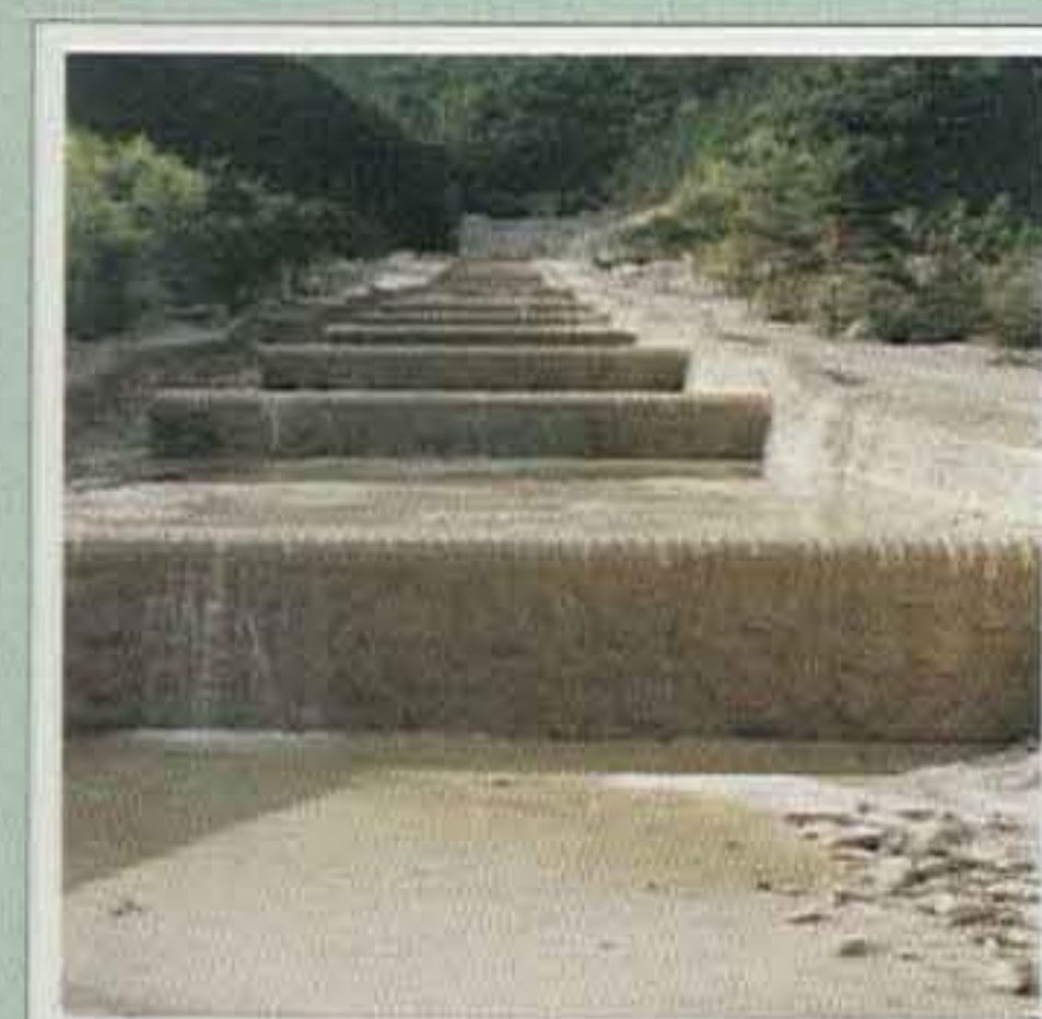
Aspecto actual. Al fondo puede observarse el Dique 2.
