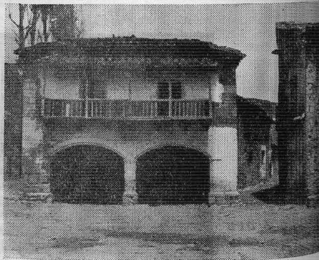
TERRIENTE. — Fachada del Ayuntamiento.
