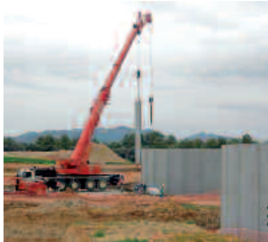
Construcción reactor biológico planta de Valderrobres: UTE Tedagua-Cobra Infraest. Hidráulicas-Cobra Instal. y Servicios.
