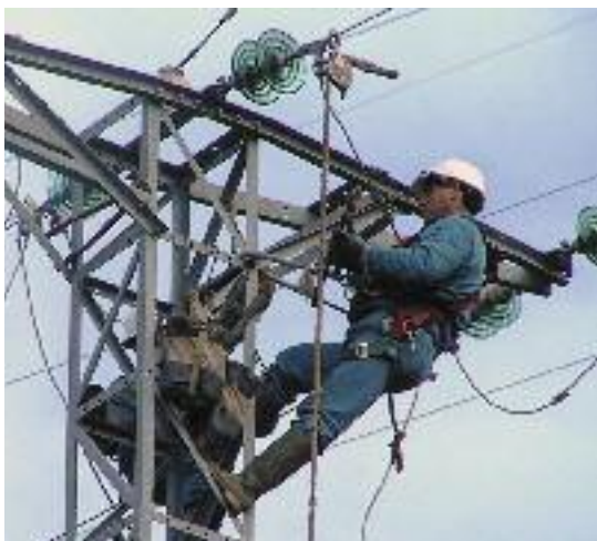
Trabajos de adecuación de tendidos eléctricos. (Departamento de Medio Ambiente)
