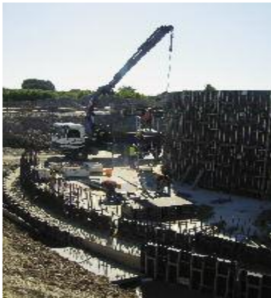
Encofrado reactor biológico en Burgo de Ebro.
