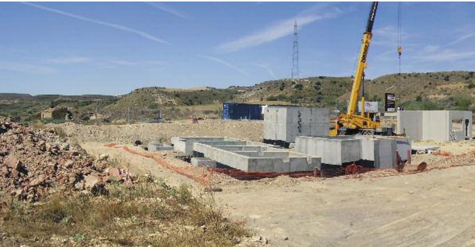
Colocación de panel prefabricado en Ontiñena.
