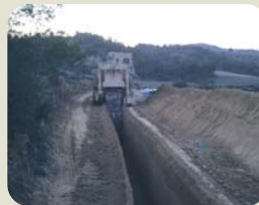
Apertura de zanja mediante zanjadora
