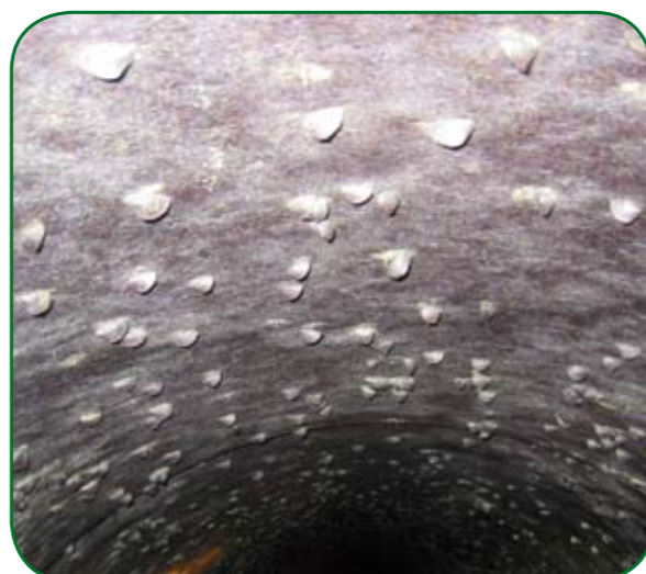
Tubería con ejemplares aislados de mejillón cebra en una Comunidad de Regantes Aragonesa en 2008.
