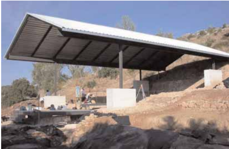
Vista exterior de la cubierta de la Curia de Labilolosa
