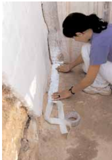
Colocación de cinta de aluminio sobre el pavimento de H13
