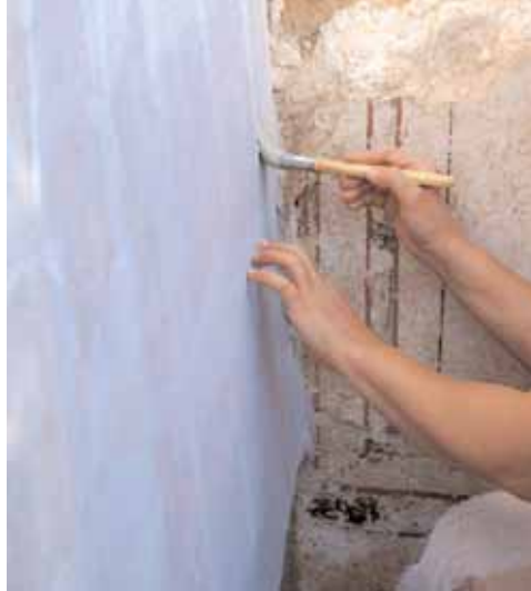
Engasado con veladina y solución acuosa y resina acrílica al 20%
