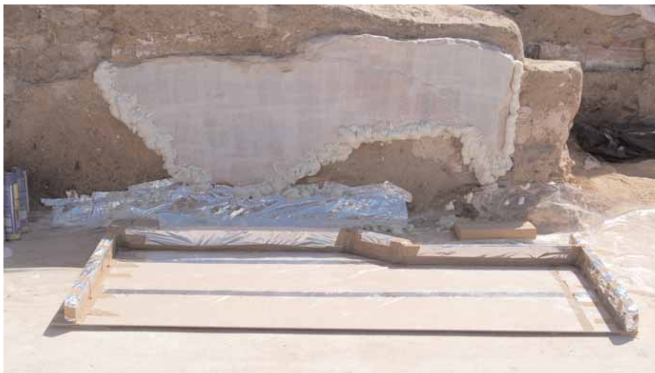
Preparación del soporte rígido previo al arranque de H 6
