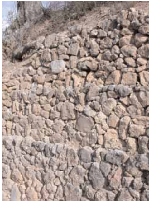
Paredes de los bancales tradicionales construidos por los campesinos
