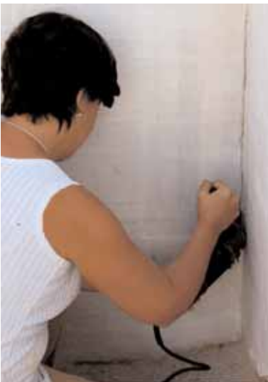
Cortes realizados con la radial sobre los muros de H13
