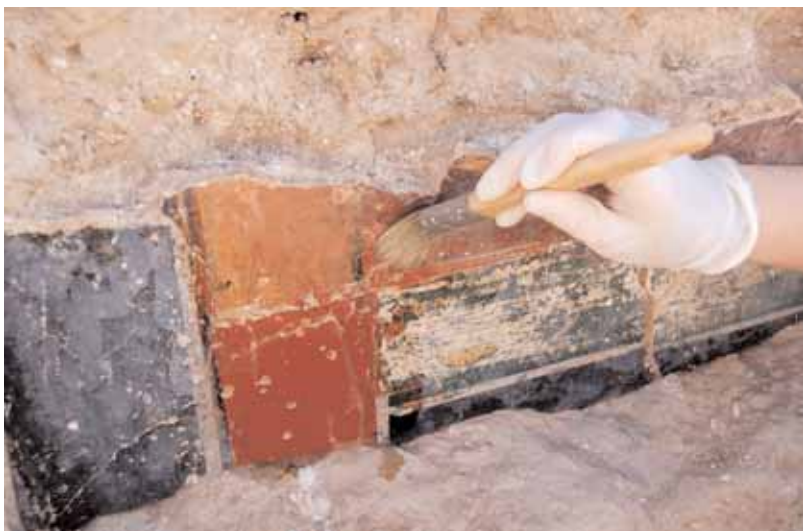
Consolidación previa al empapelado, con resina acrílica en acetona en el muro de H6
