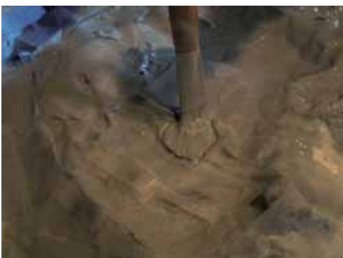
Tamponado del velo de fibra de vidrio
