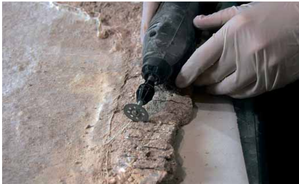
Rebaje de morteros con drémel
