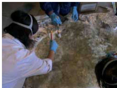
Aplicación de la segunda capa de poliéster
