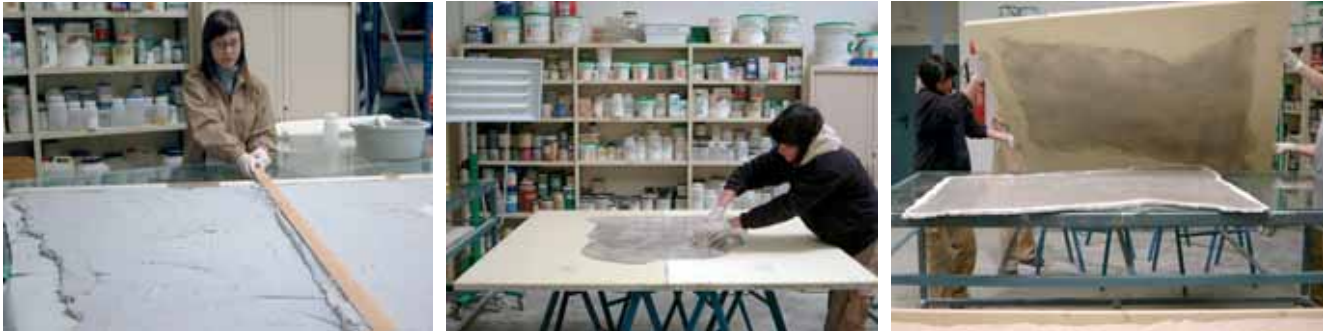
Aplicación del mortero de nivelación en el reverso, aplicación de la resina epoxi y adhesión del soporte a la placa de pintura
