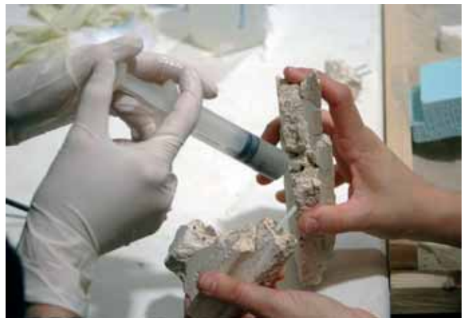
Detalle de la colocación de espigas en las pilastras
