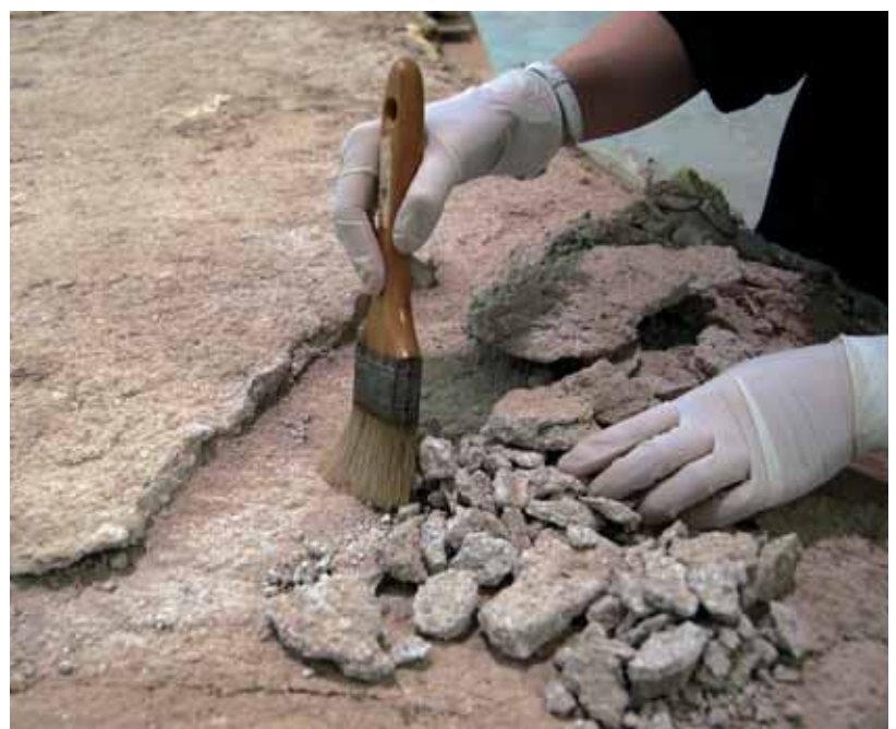
Eliminación de mortero original
