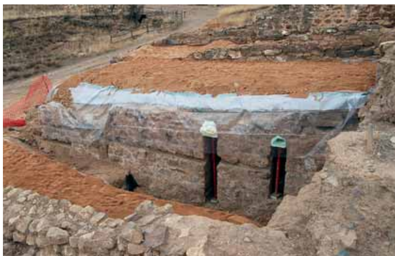
Intervención sobre el muro norte de H. 20 y cubrimiento provisional
