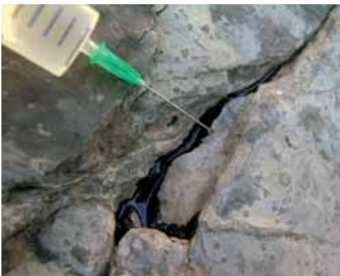
Inyección de resina
