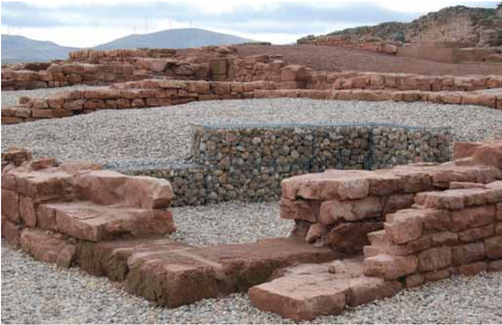
Reconstrucción estructural con el sistema de gaviones en el yacimiento de Tiermes (Soria)
