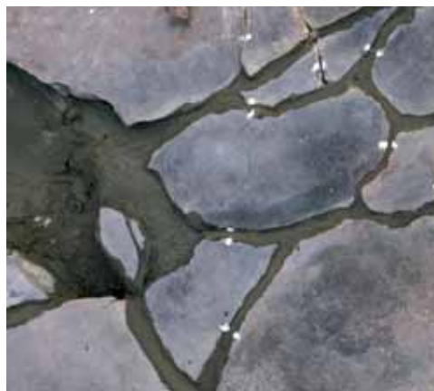
Mortero aplicado entre las grietas
