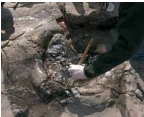
Aplicación de desmoldeante
