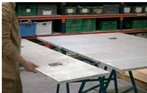
Colocación de un empalme con espigas de acero
