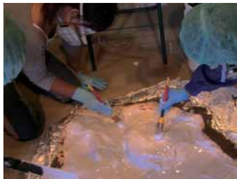
Vertido de primera capa de resina de poliéster
