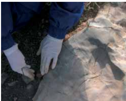
Relleno de grietas y delimitación de la zona
