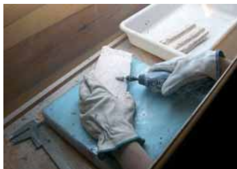
Rebaje de los morteros con drémel
