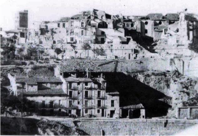
Vista de las destrucciones causadas en los edificios del sector sur de Teruel.
