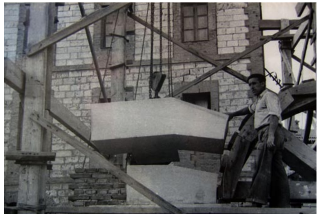
Colocación de dovelas en el porche del edificio destinado a Jefatura de Ingenieros, en la plaza de San Juan.
