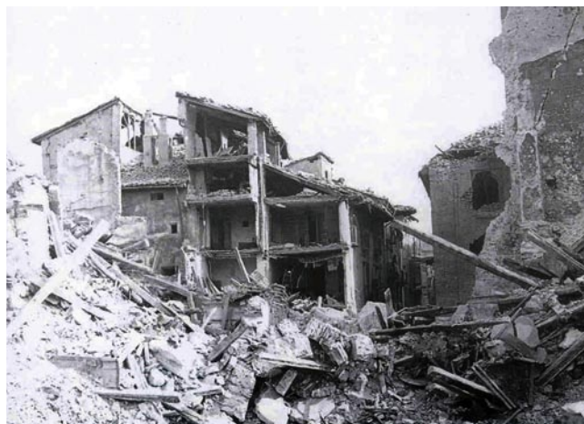
Escombros cegando la calle de Yague de Salas.
