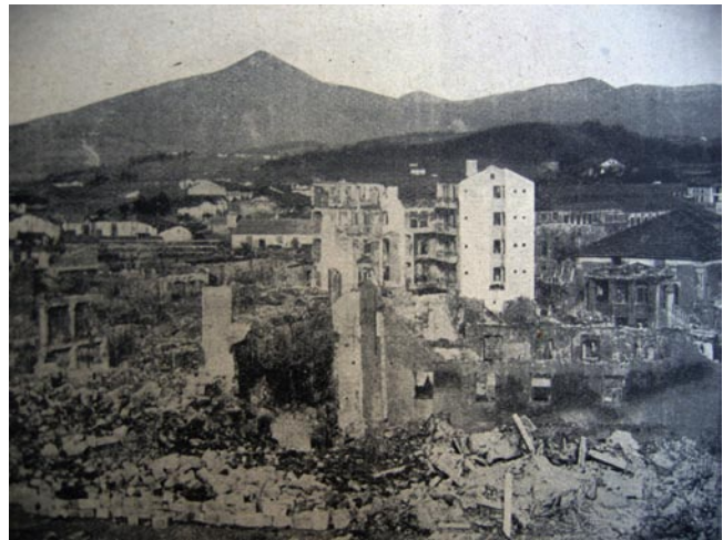
Ruinas de Guernica. Las destrucciones masivas producidas en el frente del norte de España impulsaron al Gobierno de Burgos a crear el Servicio de Regiones Devastadas y Reparaciones.
