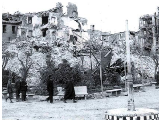
Ruinas del Gobierno Civil, Delegación de Hacienda, Banco Hispano Americano y Jefatura de Obras Públicas
