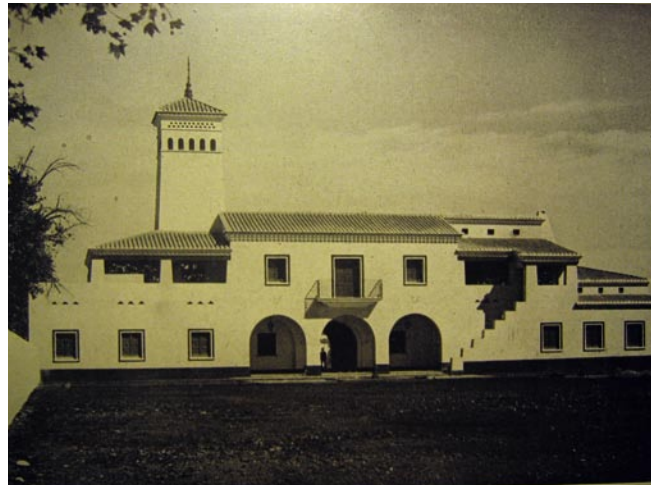
Las construcciones de la Dirección General de Regiones Devastadas incorporan elementos tomados de la arquitectura popular, como los porches, las solanas, las escaleras exteriores o las torres palomar, como sucede en la escuela granja de Nules.
