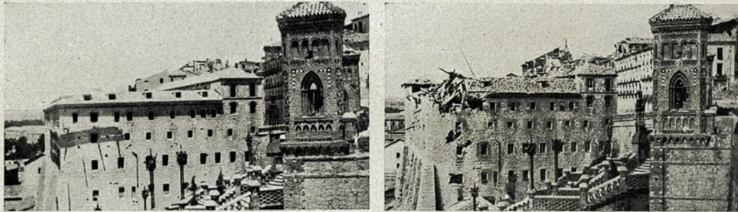
Obras de reparación del Cuartel de Carmelitas. Fotos comparativas.
