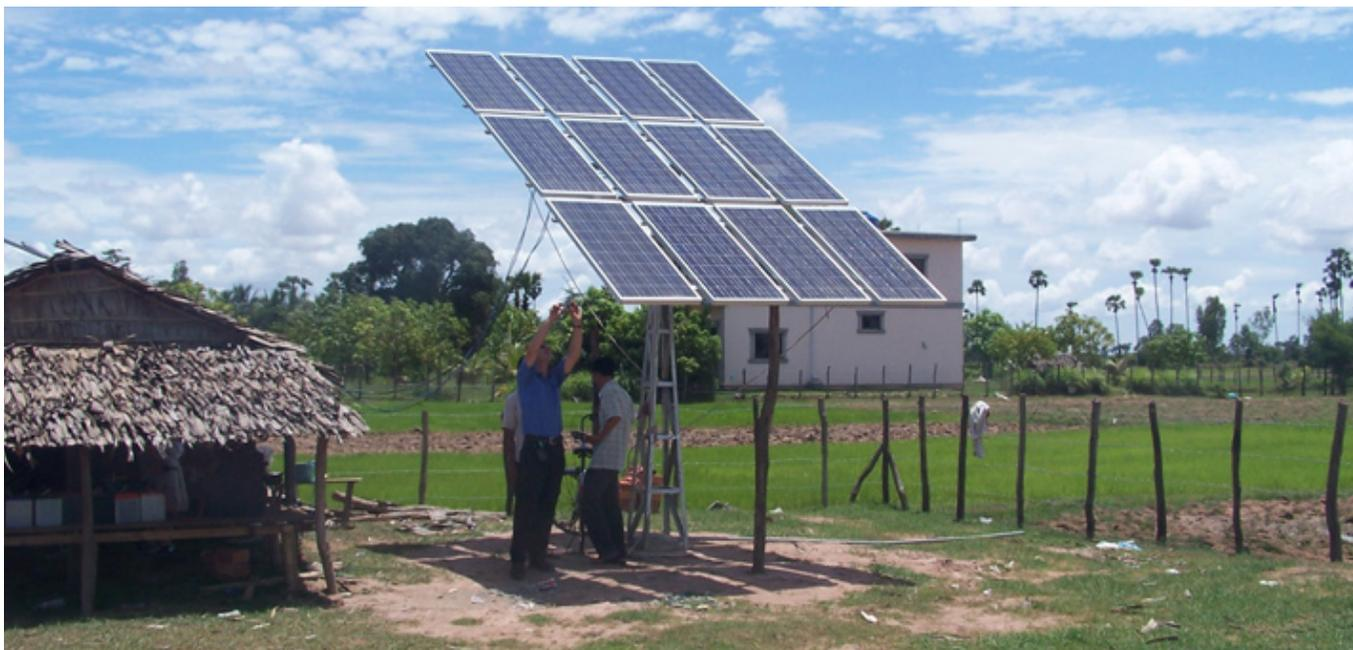
*En Daeum Popel se ha usado un sistema híbrido de fotovoltaica y diésel para cargar baterías. Fotos de Energy for Life.*
