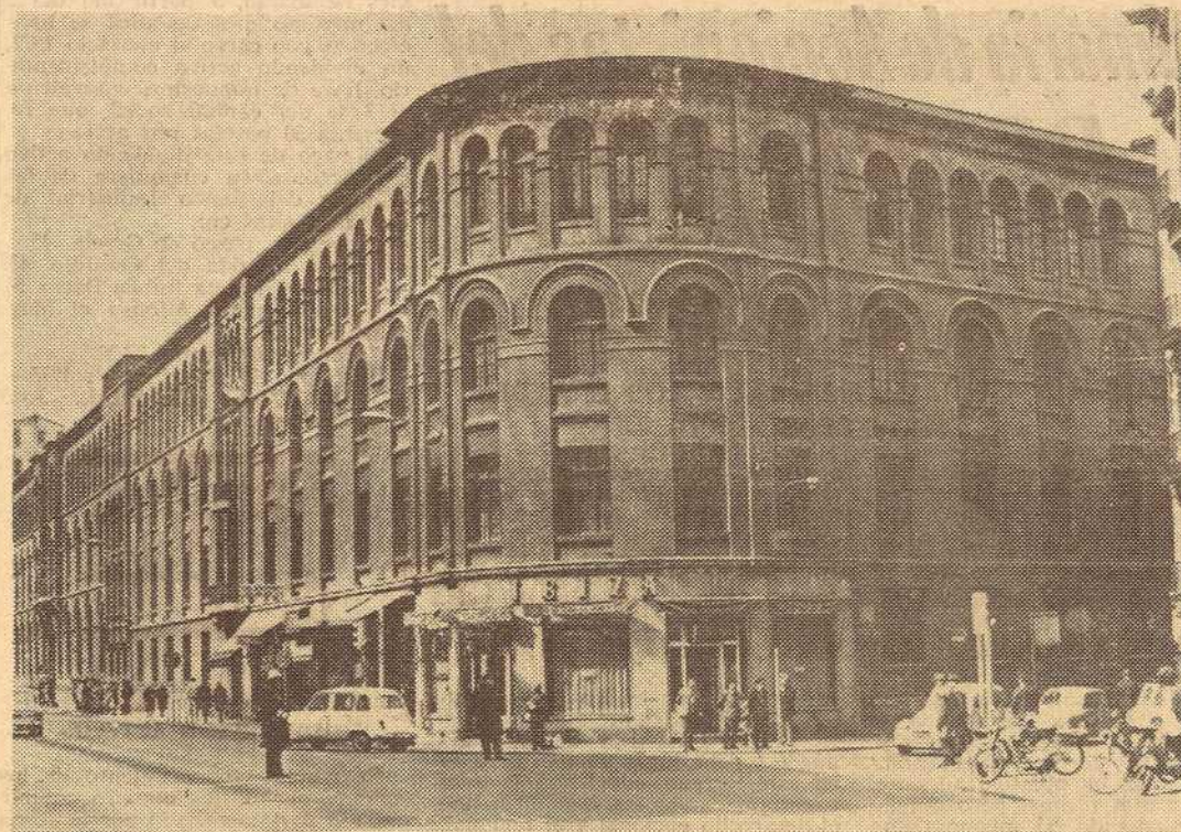
El actual Colegio de los Escolapios, que será derruido para dar paso a la Vía Imperial (Foto MONGE.)
