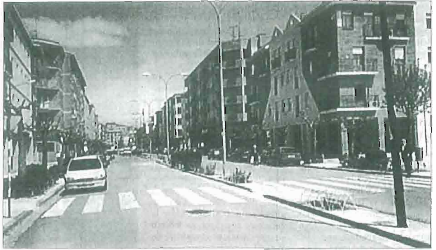
La avenida de Cosculluela será una de las actuaciones incluidas en la remodelación del Ensanche.
