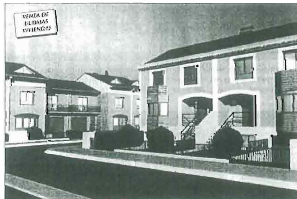
Urbanización «Residencial Vega de Luchán» Ejea
