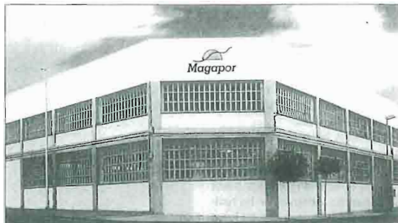
Sede central de Magapor en Ejeja.
