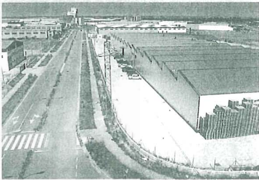
Un aspecto del Polígono Industrial de Valdeferrín.
