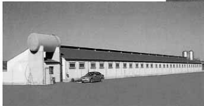
NAVE DE PORCINO
