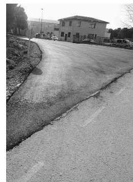
El Bayo. Acceso a Horticola Cinco Villas.
