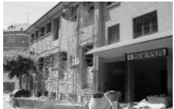
Obras en el Mercado Municipal.
