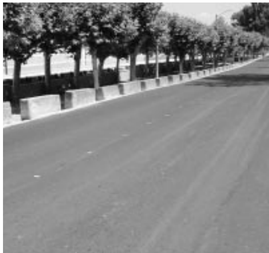
La carretera de Bañera con su nuevo firme.
