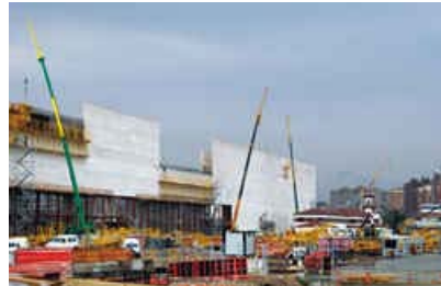
Estado de las obras de la Estación Intermodal de Delicias
