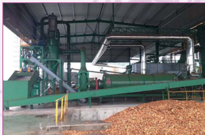
Instalación de secado de la biomasa en Planta de Cogeneración de biomasa con tecnología de gasificación de IDERMA GENERACIÓN de 2 MW (Ejea de los Caballeros, Zaragoza)
