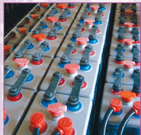
Asociación de baterías. Instalación fotovoltaica aislada en vivienda (Huesca)
