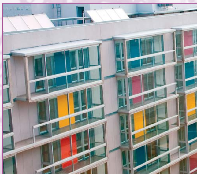
Paneles solares en cubierta de vivienda. (Ecociudad Valdespartera, Zaragoza)
