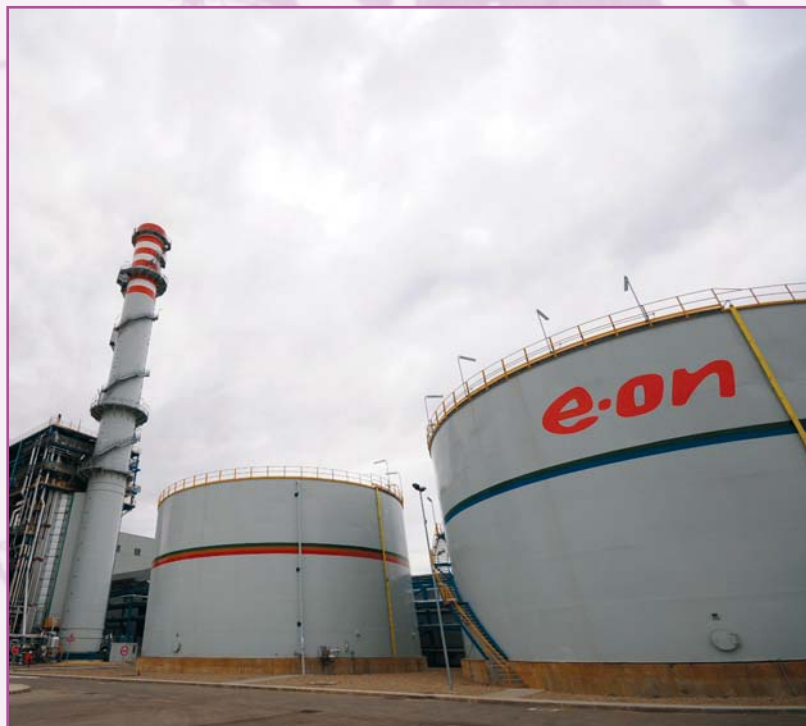
Central de ciclo combinado (Escatrón, Zaragoza)
