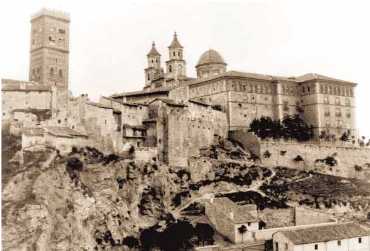
Flanco noroccidental de la muralla, entre la Torre de San Martín y el antiguo Seminario. El pronunciado escarpe rocoso reforzaba especialmente las defensas de ese sector de la villa.
