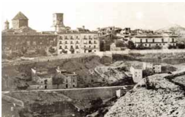
La muralla en las inmediaciones del Portal de Valencia. Se aprecia un parapeto para fusilería realizado durante las Guerras Carlistas, que descansaba sobre el almenado del muro medieval.
