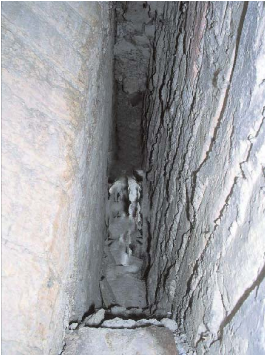
A la izquierda: Grieta entre la torre (a la izquierda) y el muro hastial de la iglesia (a la derecha), donde se aprecian las rebajas de este último.
