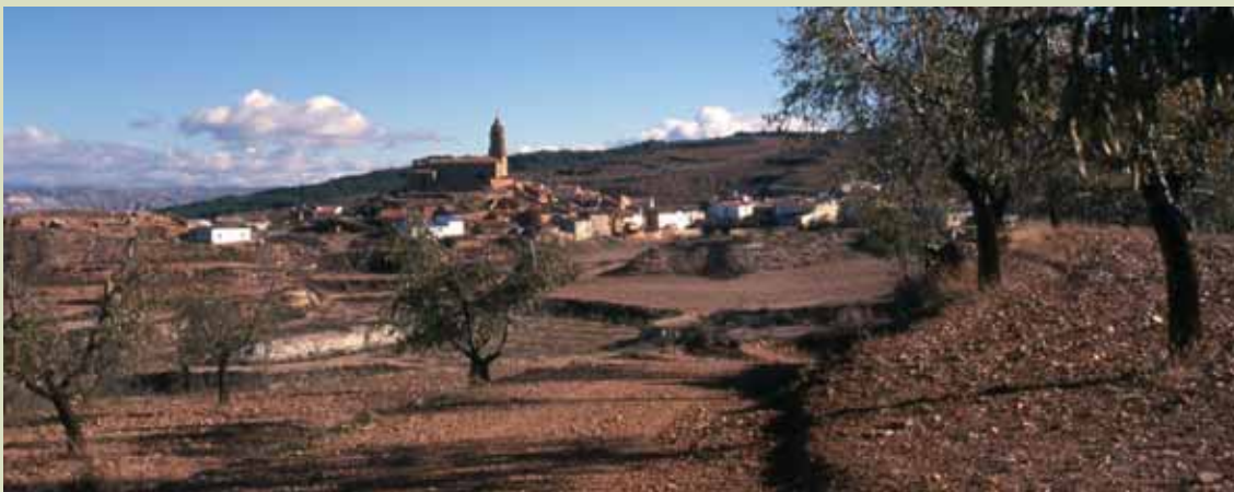
Panorámica desde el pilar de Santa Lucía.
