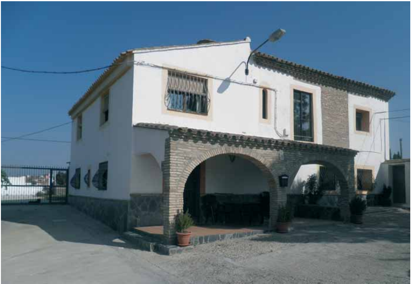
En esta casa puede todavía apreciarse la existencia de una torre que vigilaba el conjunto. Ahora está reformada.
