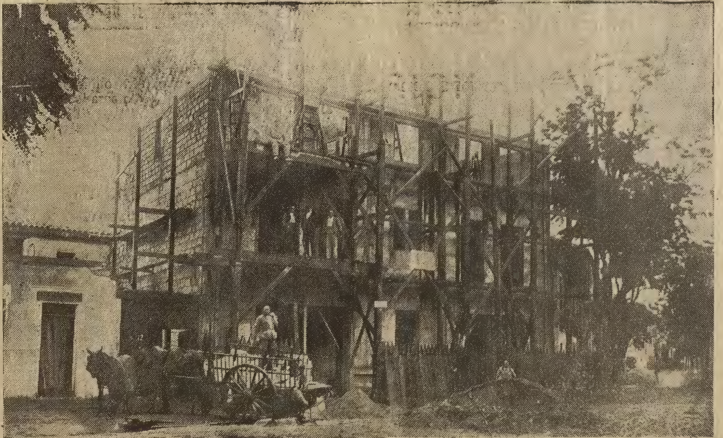
La construcción de viviendas de hormigón armado.—Casa en construcción contratada por el joven aparejador de obras D. Isidro Aznar, en el Arrabal (Fot. A. de la Barrera)
