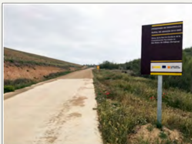
Cartel de obra e inicio camino
