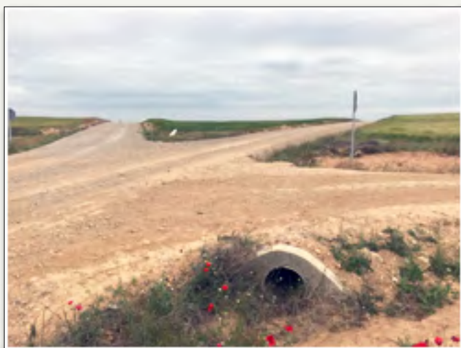
Detalle paso salvacunetas
