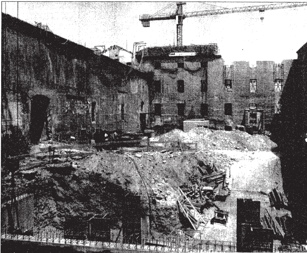
Los restos hallados se han encontrado al realizar las excavaciones previas a las obras de ampliación de las Cortes de Aragón.
