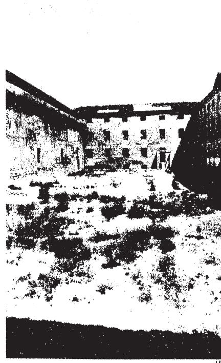
Situación actual del patio occidental.
