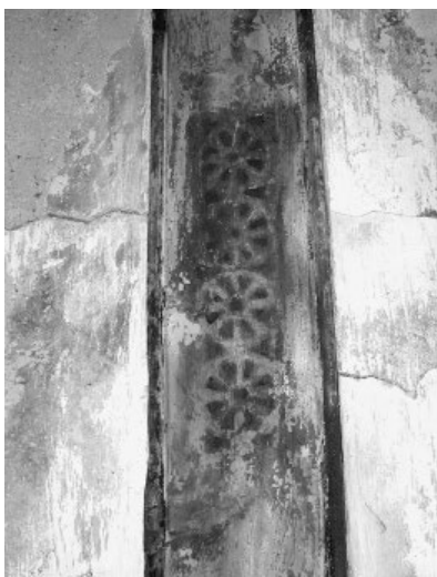
Fig. 6. Decoración de viga, vista desde la planta baja.
