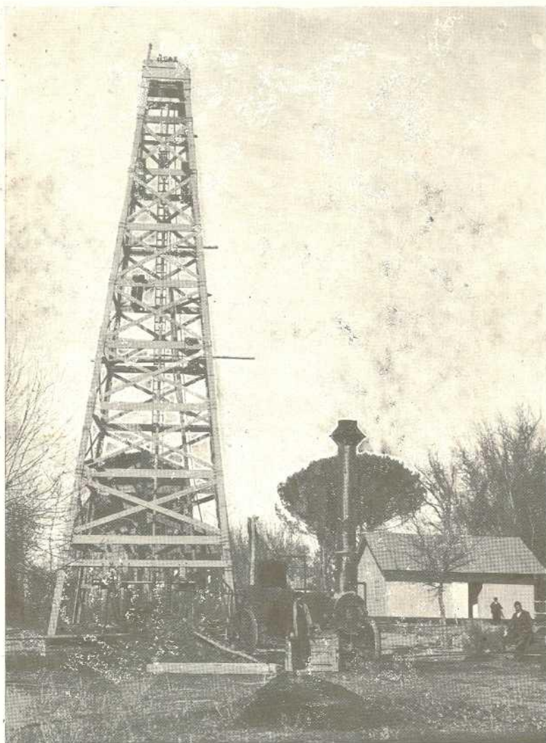
Equipo (norte-americano) de sonda rotatoria para perforaciones artesianas, accionado a vapor; con inyección a gran presión de agua cargada de arcilla, al objeto de evitar las taponadas de arena.
