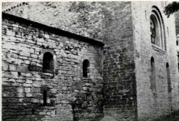
Monasterio Viejo: Muro que da al barranco (después de la última reparación).
