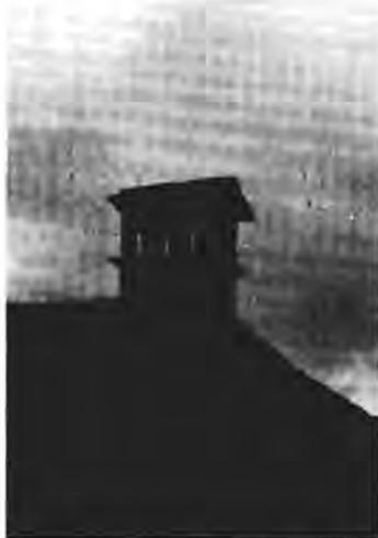
**Fig. 17.** *Ansó.* Chimenea rectangular. Fabricada en piedra "tosca" parcialmente revestida. Hilada de abertura en piloncillos rectangulares. Tejadillo de cubrición a dos "aguas".
