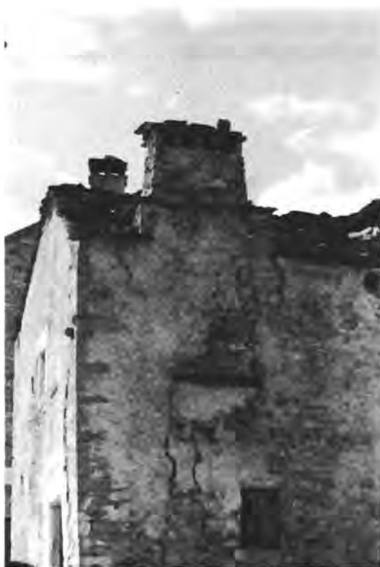
**Fig. 7.** *Aso de Sobremonte*. Chimenea rectangular. Remate en un lateral del tejadillo. Sobresale, en el muro, el *fogaril*.
