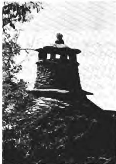
**Fig. 20.** *Lárrede (casa Borrés).* Chimenea cilíndrica, situada en la unión de las cuatro vertientes del tejado. Fabricada en "tosca" sin revestir. Remate, sobre tejadillo, *antropomórfico*.
