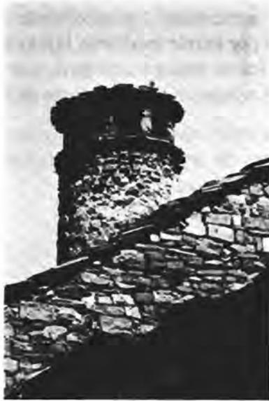
**Fig. 16.** *Embún.* Chimenea cilíndrica. Fabricada con pequeñas piedras de "tosca". Hilada de aberturas en forma rectangular, con piloncillos del mismo material. Trabada con mortero pobre de arena. Tejadillo de lascas, plano.
