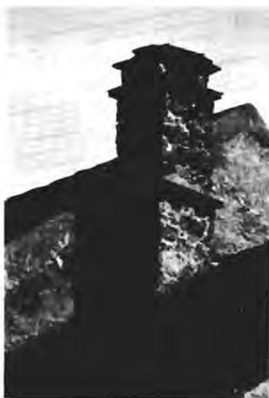
**Fig. 5.** *Echo*. Chimenea rectangular adosada, en parte, al muro. Fabricada en piedra tosca. Collarines de lasca caliza. Hilada de aberturas. Tejadillo plano.
