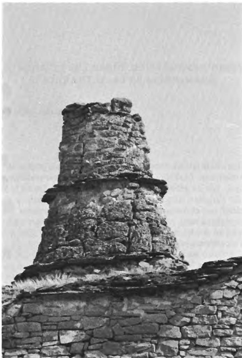
**Fig. 1. *Javierrelatre*.** Resto de chimenea monumental. Fabricada en tosca, no revestida. Dos collarines de lascas calizas.
