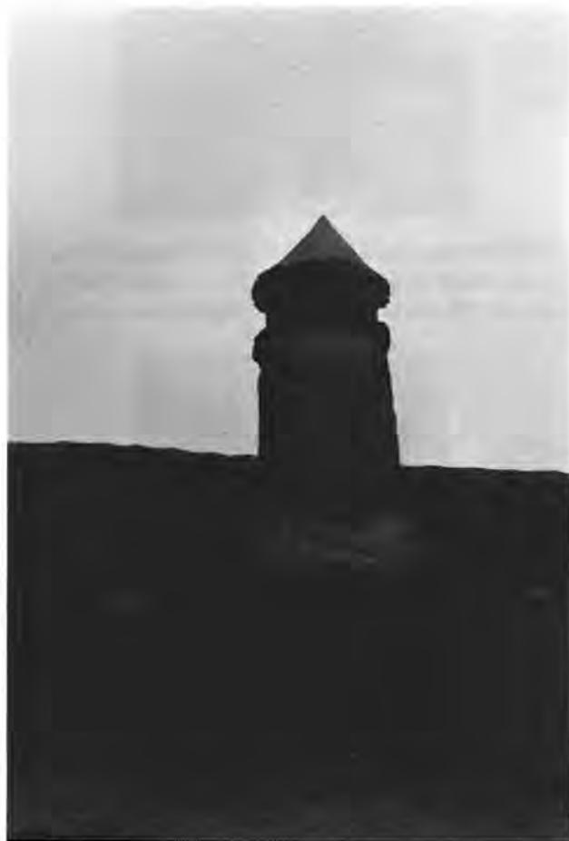
Fig. 15. *Valle de Ansó*. Chimenea troncocónica. Piedra "tosca" trabada con mortero. Resalto de lascas en la base. Coronada en cono revestido del mismo material.
