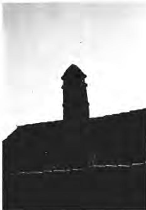
**Fig. 3.** *Echo*. Monumental chimenea troncocónica. Collarines. Fabricada en piedra "tosca", revestida con mortero pobre. Hilada de abertura para salida de humos. Sombrete cónico.
