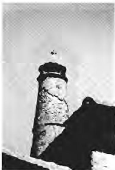
Fig. 14. *Echo*. Monumental chimenea troncocónica. Fabricada en "tosca" revestida. Hilada de aberturas en zig-zag. Tejadillo en forma de cono. Remate *cruciforme*.
