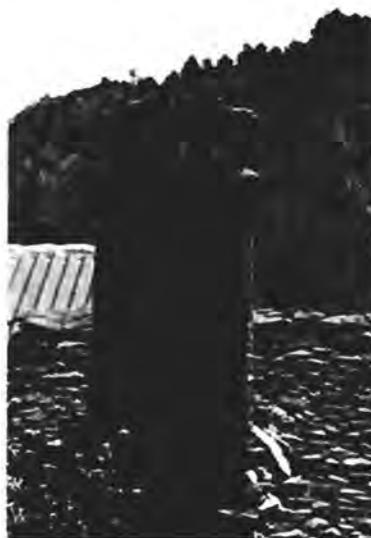
**Fig. 6.** *Santa Cruz de la Serós*. Gran chimenea rectangular. Fabricada con piedra caliza. Hilada de aberturas con pilones rectangulares. Remate *geométrico*, en "tosca".
