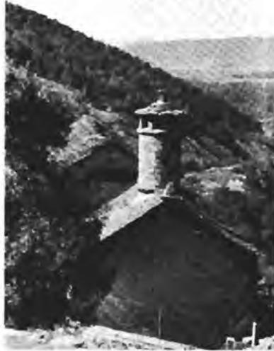
**Fig. 19.** *Oliván.* Chimenea cilíndrica. Situada en medio del caballete del tejado. Fabricada en "tosca", con una hilada de aberturas para la salida de humos. Remate, sobre tejadillo de lascas calizas, *geométrico*.
