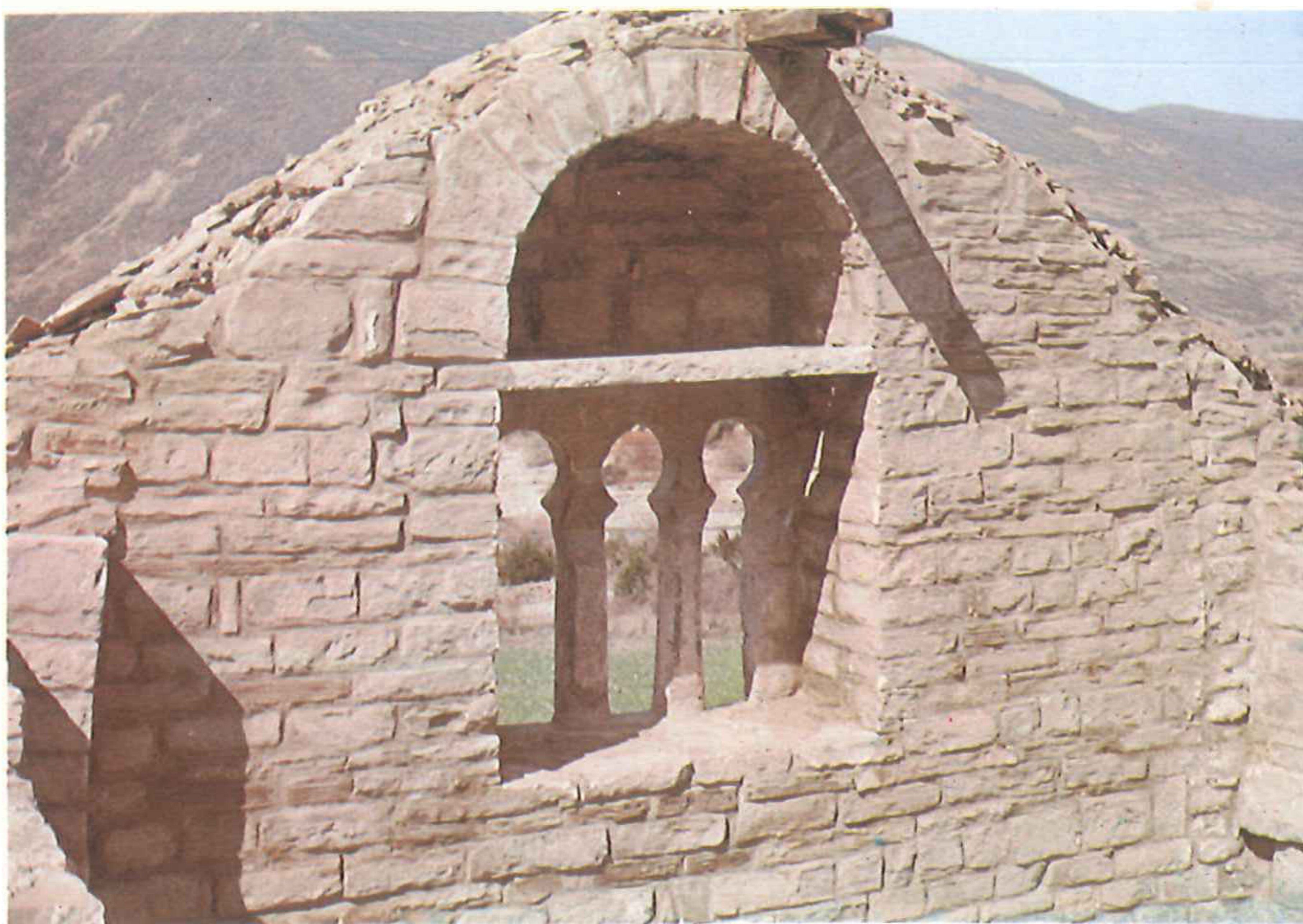
SAN JUAN DE BUSA. Vista interior de la ventana restaurada.
