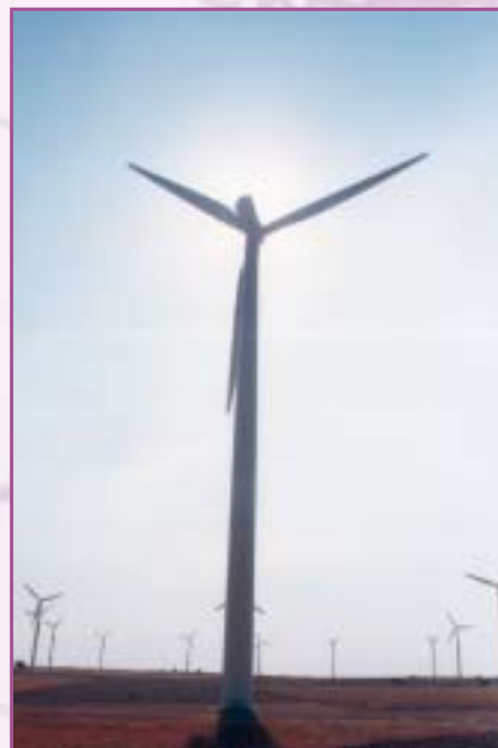
Parque Eólico en la Plana de Zaragoza
