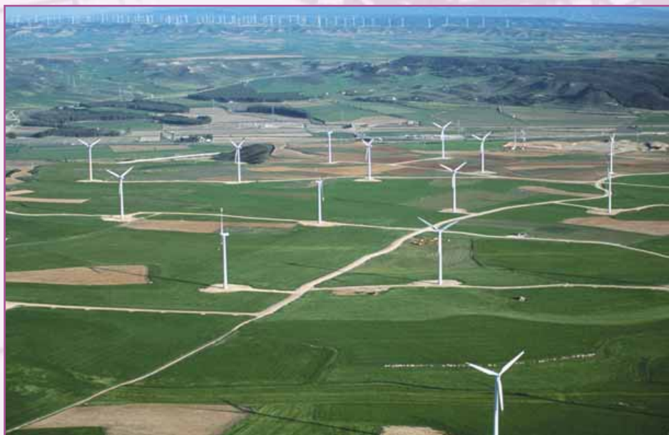
Parque eólico Río Gállego (Huesca). 36 MW.
