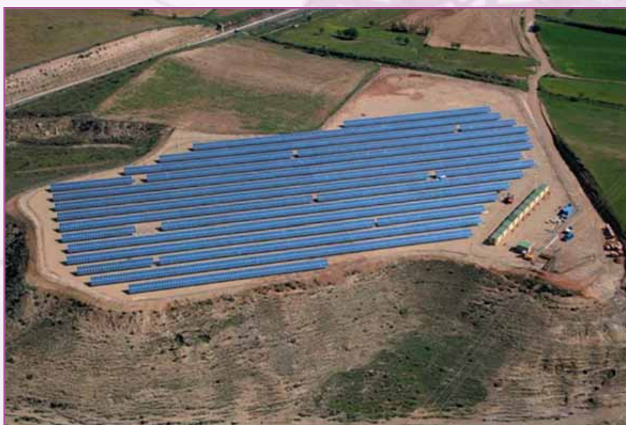
Instalación solar de 1 MW. Tardienta (Huesca).
