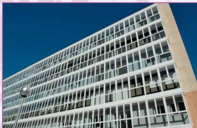
Arquitectura bioclimática. Barrio de Valdespartera (Zaragoza).
