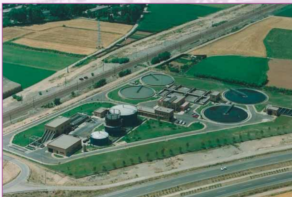
Depuradora de La Almozara (Zaragoza). Cogeneración de biogás de 0,22 MW.
