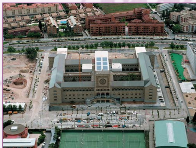
Energía Solar Fotovoltaica en cubierta Seminario Zaragoza
