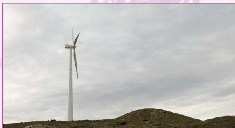
Parque Eólico de Jaulín. 4,5 MW (Zaragoza)
