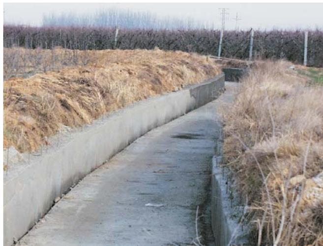
El revestimiento de las acequias se traduce en una mayor capacidad de transporte, además de una disminución de pérdidas de agua en las conducciones.
