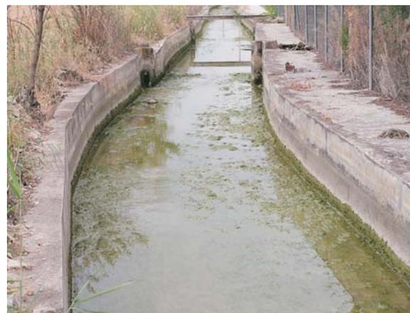
Las acequias al descubierto tienen un mayor coste en mantenimiento ya que la luz favorece la aparición de algas, las cuales dificultan el transporte del agua.
