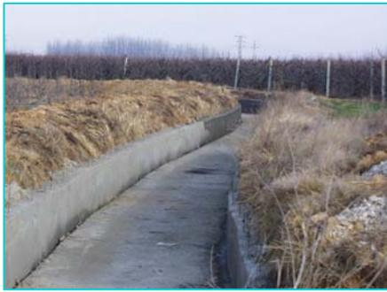
Foto2: El revestimiento de las acequias se traduce en una mayor capacidad de transporte, además de una disminución de pérdidas de agua en las conducciones.
