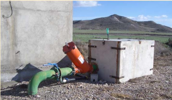
Foto (3): cabezal de entrada sin válvula maestra.
