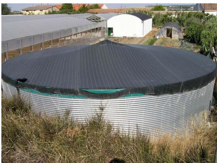
Foto 2: En instalaciones en las que un mal funcionamiento de los equipos de riego suponen una gran inversión, como invernaderos, se protegen los depósitos de agua con mallas.
