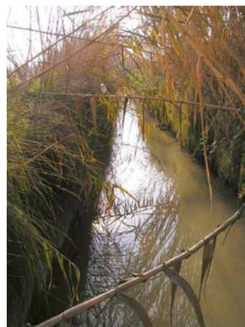
Foto1: Las acequias de tierra presentan una elevada rugosidad, por lo que la velocidad de transporte y el caudal resultan inferiores a las de acequias de hormigón de las mismas dimensiones.
