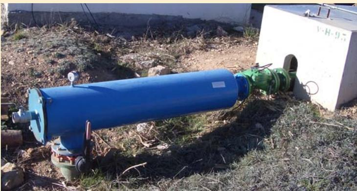
Foto (4): cabezal de entrada con válvula maestra.
