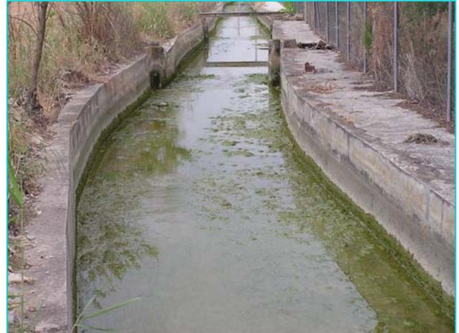
Foto 3: Las acequias al descubierto tienen un mayor coste en mantenimiento ya que la luz favorece la aparición de algas, las cuales dificultan el transporte del agua.
