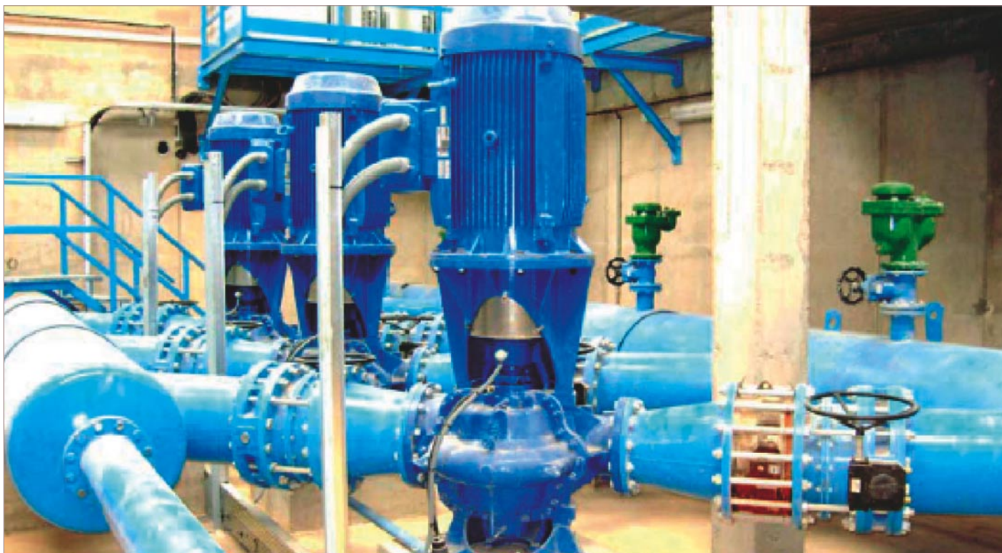
Foto 2: Estación de bombeo. Instalación de bombas en posición vertical
