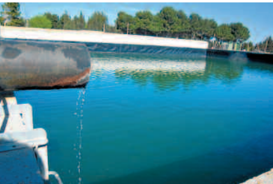
Potabilizadora de abastecimiento de la Mancomunidad de Aguas de Monegros.
