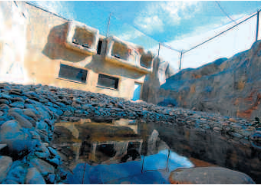
Imagen del voladero exterior del Centro de Cría en Aislamiento Humano, dotado de nidos artificiales.
