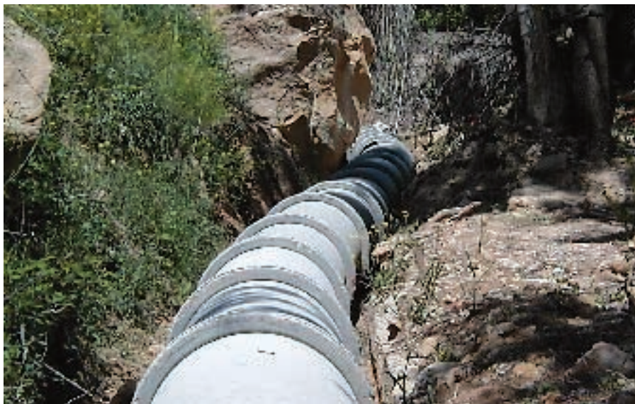
Regadíos. Creación y mejora de los sistemas de riego.
