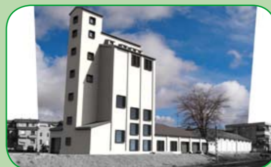
Futura OCA de Ariza. Las grandes aperturas acristaladas practicadas en fachada y que comunican con las antiguas celdas, permitirán un ahorro de calefacción en invierno. En verano las lamas calculadas al efecto, protegerán de la radiación solar y la convección creada en cada una de las celdas, favorecerá la ventilación y disminuirá la carga térmica.
