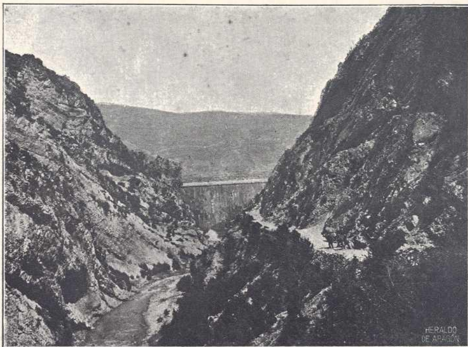
Pantano de Argüis. Vista desde aguas abajo
